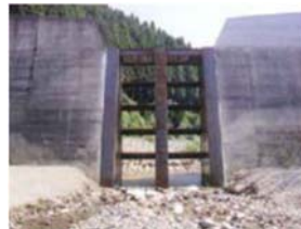
透過型砂防堰堤防
