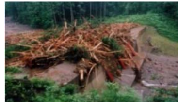
流木捕捉式治山ダム
