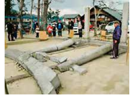
地震で倒壊した直後の鳥居 佐賀新聞社提供
