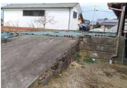
ここにあった水屋は昭和28年の水害のあとに解体されましたが、家の近くに建てられていたことがわかります
