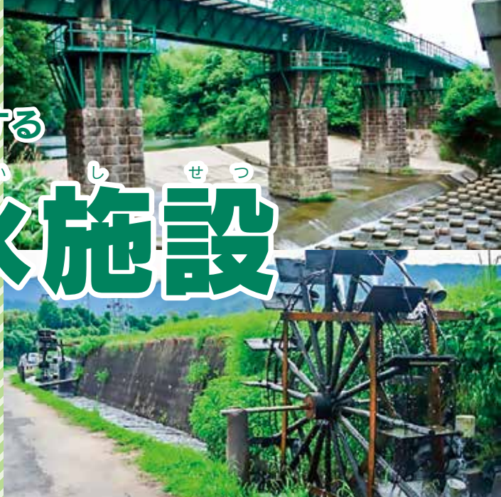
上：町切堰は厳木川の水を取りこむためにつくられました 下：現在も稼働している水車が見学できます
