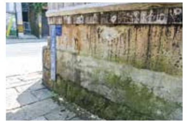
基礎の高さが一目でわかります
