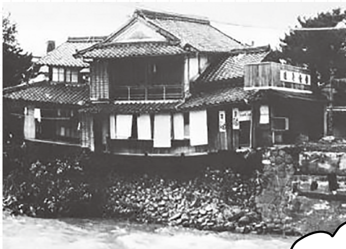
昭和37年大雨 鹿島市 鹿島市提供
