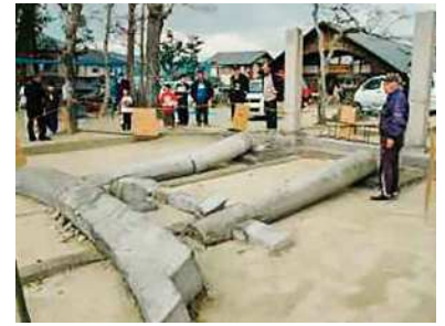
地震で倒壊した直後の鳥居 (写真提供：佐賀新聞社)
