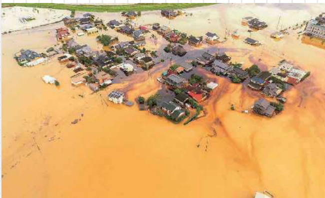
大町町（油流出）（写真提供：九州地方整備局）
