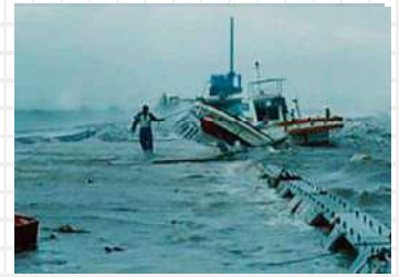
昭和60年高潮 小城市(旧芦刈町) (写真提供：武雄河川事務所)
