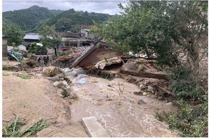
唐津市浜玉町平原（土砂災害）
