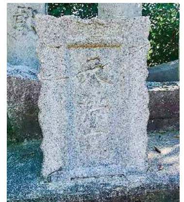
鳥居のひび割れも当時のまま残っています
