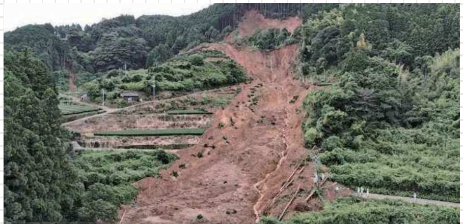
嬉野市嬉野町不動山（土砂災害）
