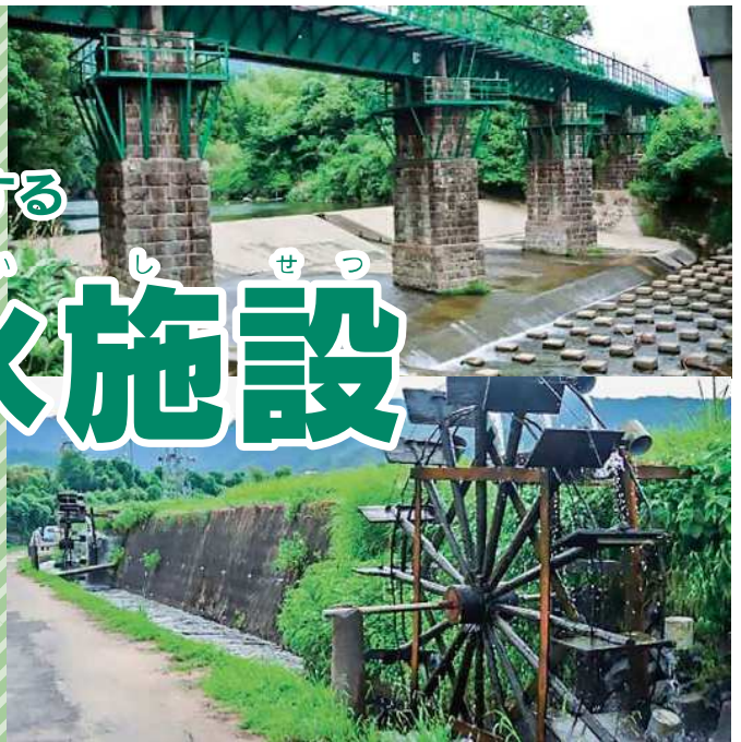
上：町切堰は巖木川の水を取りこむためにつくられました 下：現在も稼働している水車が見学できます
