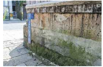
基礎の高さが一目でわかります
