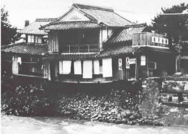
昭和37年大雨 鹿島市 （写真提供：鹿島市）
