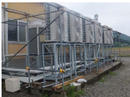
設備の嵩上げ
