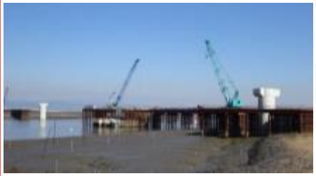
【県事業】佐賀福富道路 六角川大橋施工状況
