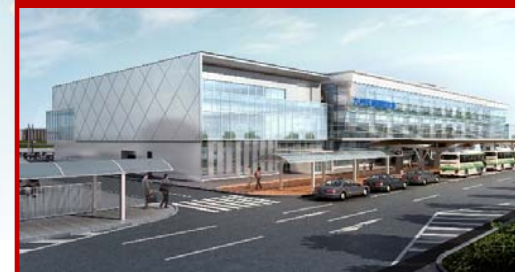
空港ターミナルビル拡張
