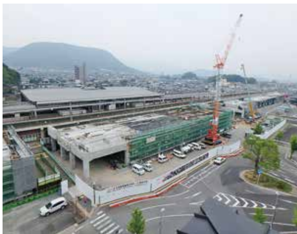
武雄温泉駅の工事状況(令和元年6月)
