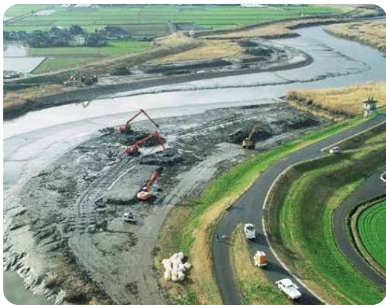
▲牛津川河道掘削状況 (出典:武雄河川事務所HP)
