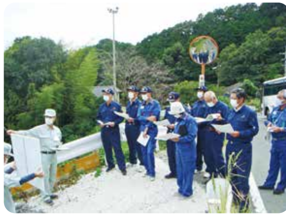
▲8月豪雨の被災状況(神崎市志波屋地区)の視察
