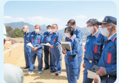
県営ため池等整備事業の視察（ため池整備工事の施工状況）
