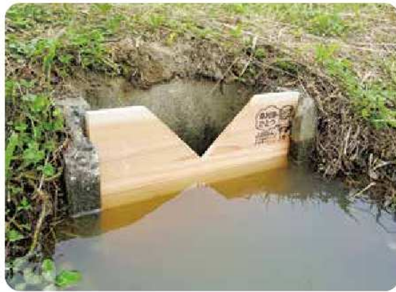
▲「田んぼダム」堰板の設置状況
