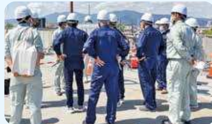
国道263号「サンライズ工区」 (上部工架設の状況)
