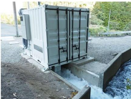
水力発電に必要な水車・発電機等をコンテナ型の建屋に収納し、パッケージ化することで、工場で組み立てて現場でコンテナを設置するため施工性が高い。
