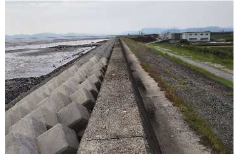
▼堤防の整備状況
