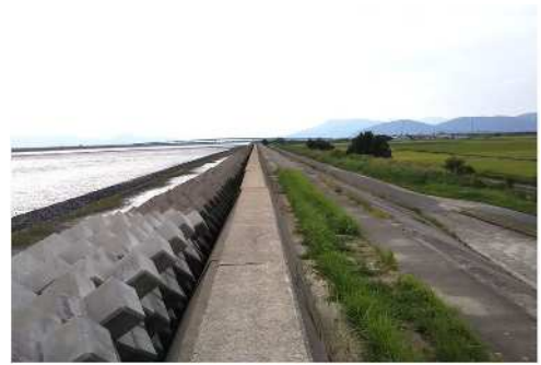
▼堤防の整備状況
