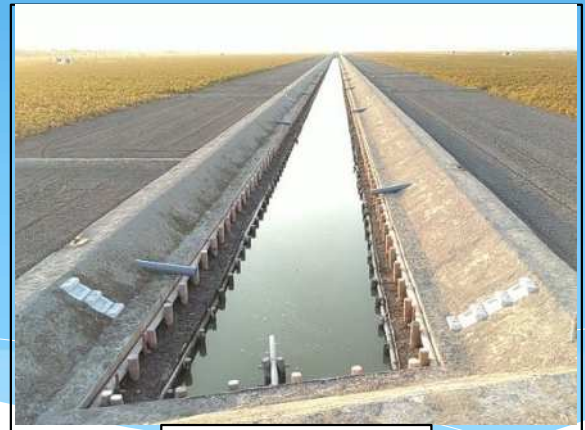
木柵による護岸整備
