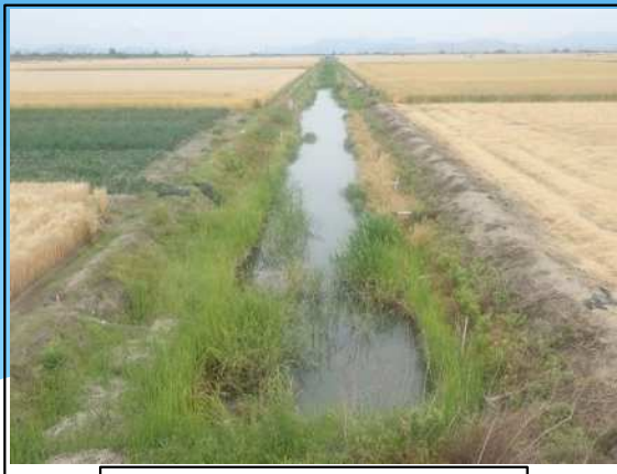
未整備のクリーク(土水路)
