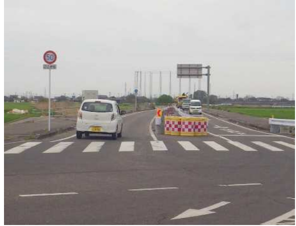
整備済区間 起点から佐賀市街方面を望む
