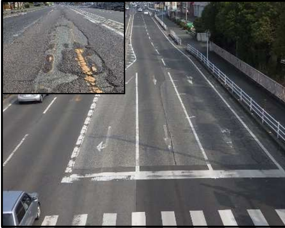
国道208号(佐賀市本庄町)
