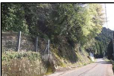
川吉平山上線(多久市西多久町板屋)
