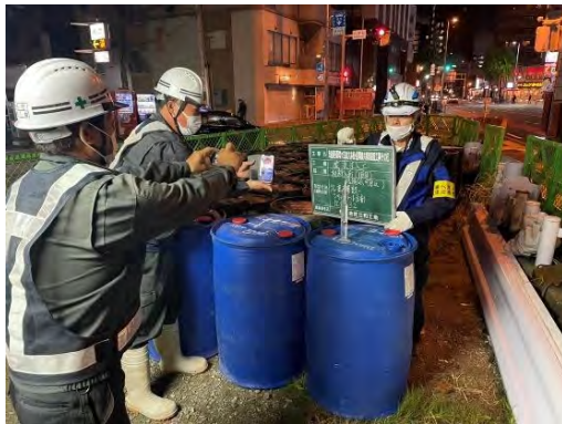
【立会状況（現場側）】
