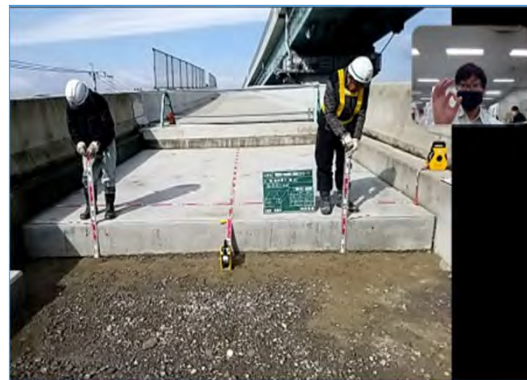
【踏掛版工の出来形検測の様子】
