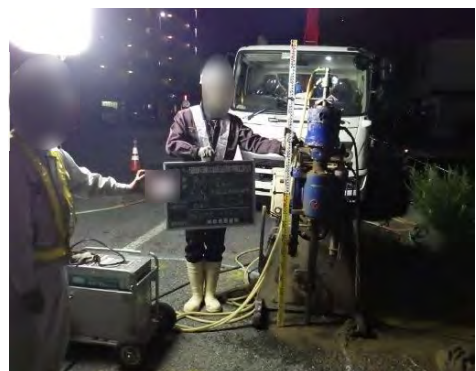
【現地状況（薬液注入口ット検尺）】
