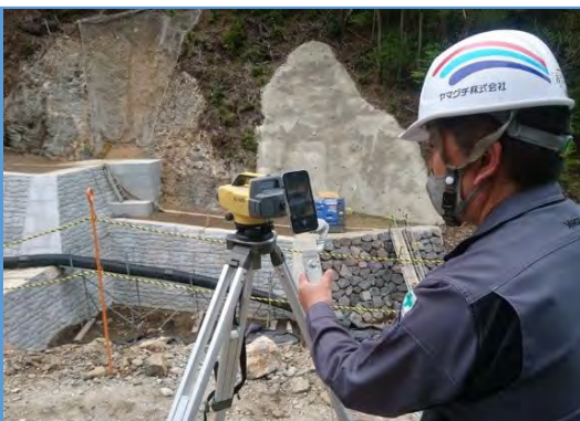
【立会状況（現場側）】
