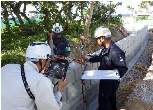
【立会状況（現場側）】
