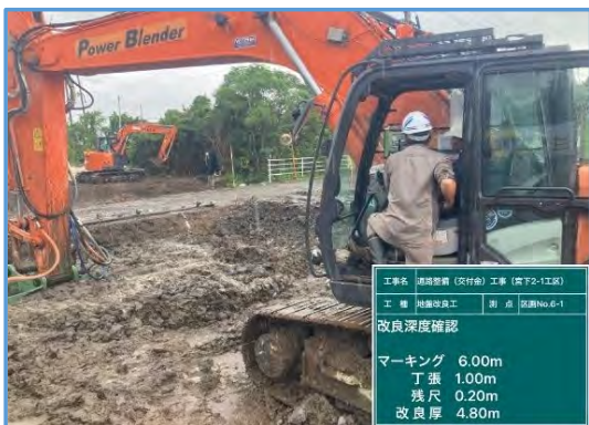
【立会状況（現場側）】
