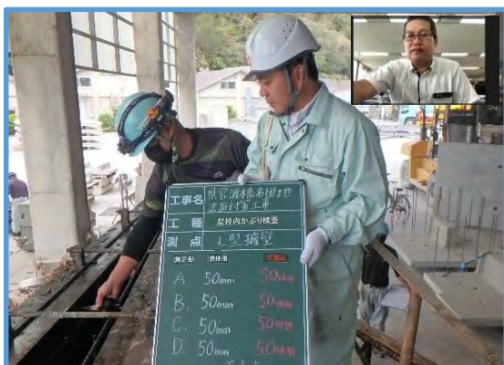
【枠内かぶり 立会状況（工場側）】
