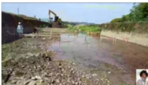
【立会状況（現場側）】
