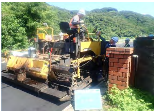
【立会状況（現場側）】
