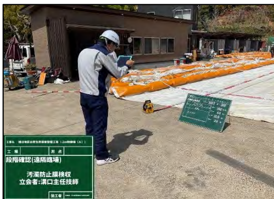
【立会状況（現場側）】
