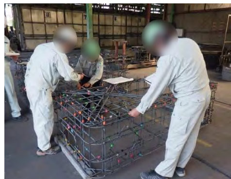
【現地状況（特殊部配筋）】
