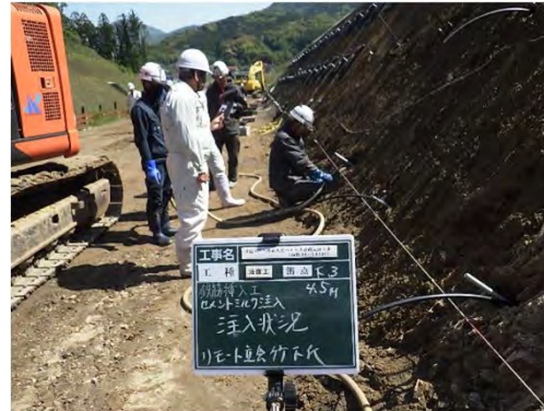
【立会状況（現場側）】
