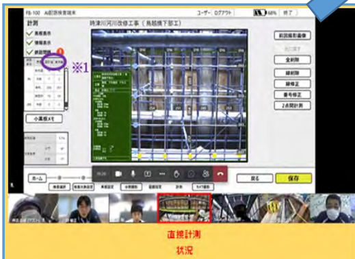
【立会状況（受発注者共有）】
