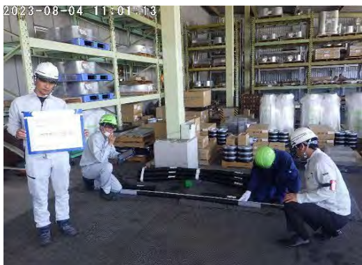
【使用材料確認（遠隔臨場）】
