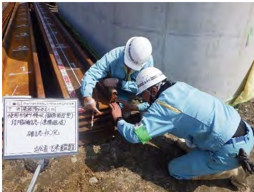
【立会状況（現場側）】
