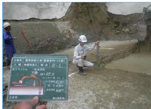
【出来形管理（杭ナビ測量）】
