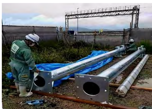
【立会状況 (現場側)】
