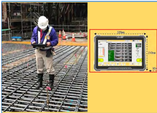
【立会状況（現場側イメージ）】
