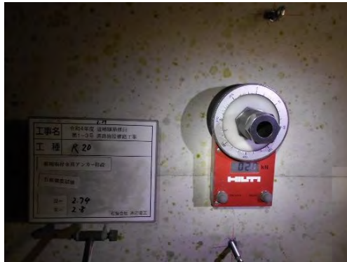
【立会状況（現場側）】
