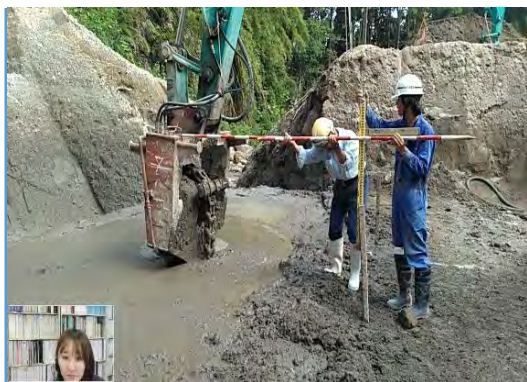
【地盤改良立会状況（現場側）】
