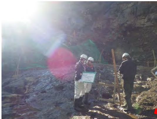
【立会状況 (現場側)】
