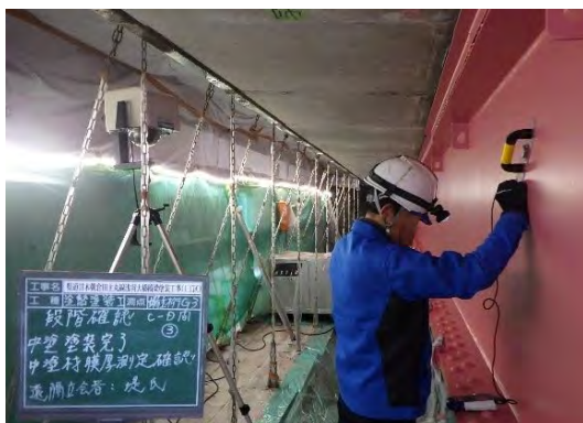
【立会状況（現場側）】
