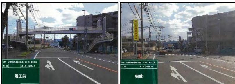
【着工前・完成】
