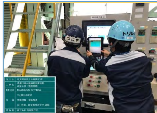
【工場試験データを写真撮影する様子】
