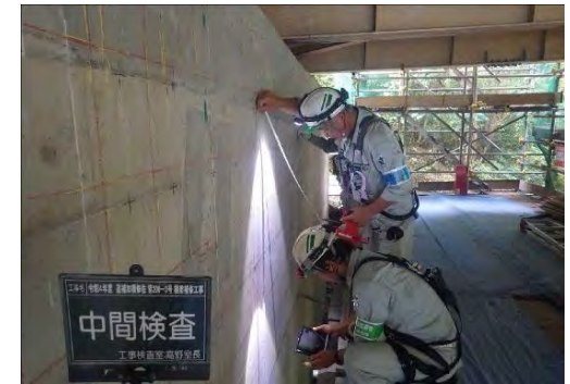
【立会状況（現場側）】
