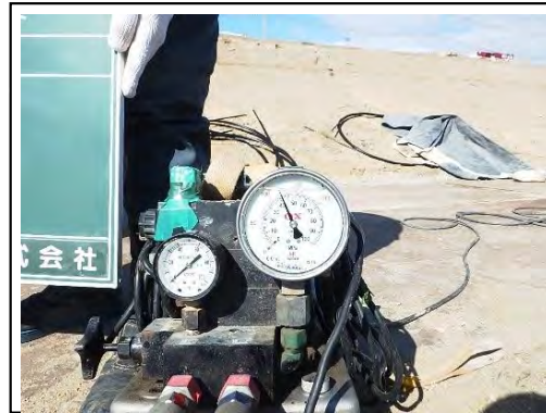
【緊張力を確認（現場側）】
