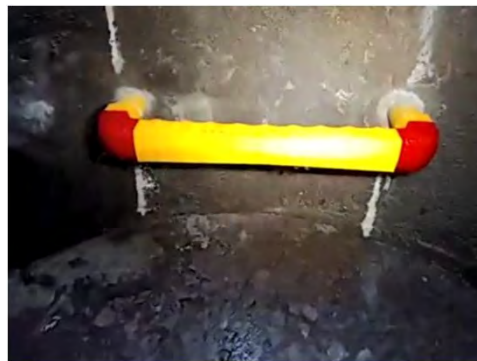
【オンライン検査（足掛金物取付確認）】
