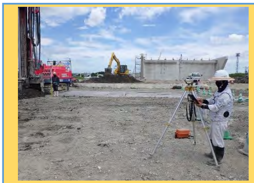
【立会状況（現場側）】
