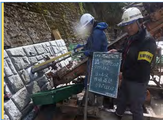
【立会状況(施工状況)】
