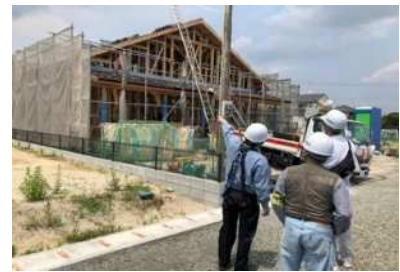
【現場安全パトロール】
