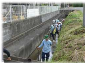
水路の泥上げ
