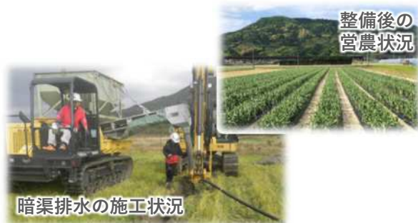
暗渠排水の整備
