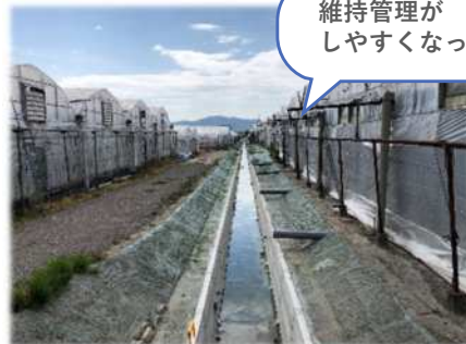
排水路の整備
