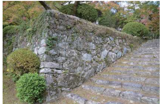
④ 03 面 (石段袖石垣)
