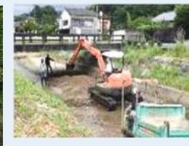
▶ 河川浚渫・伐採
