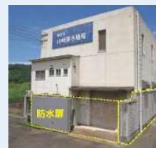
▶ 排水機場機能向上
