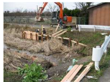
木柵による水路の 長寿命化対策
