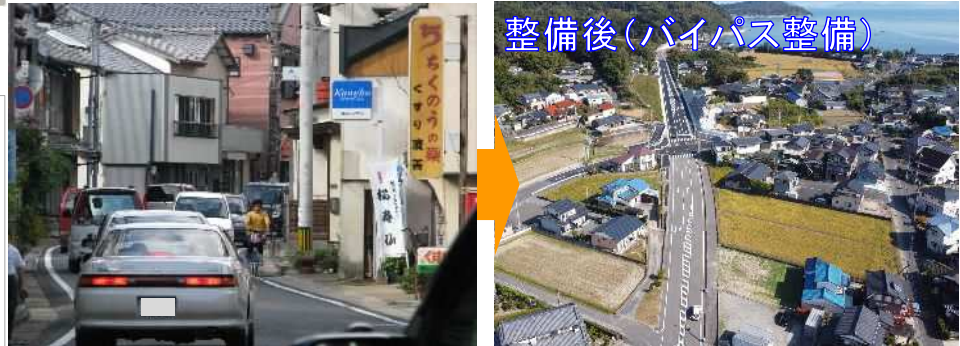
整備後(バイパス整備) バイパス整備により現道の交通混雑を緩和 一般国道204号(唐房バイパス)
