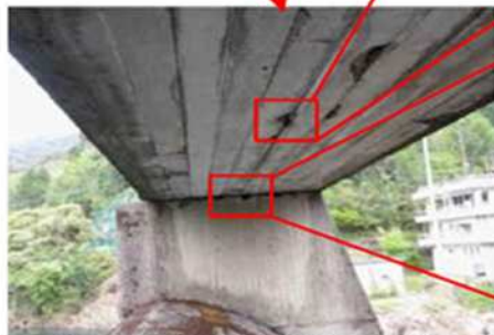
非常用洪水吐管理橋梁
