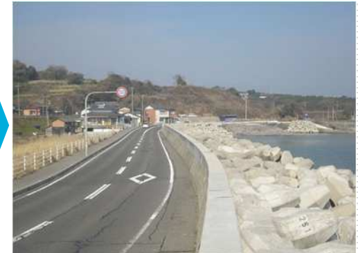
海岸堤防整備後（太良海岸）
