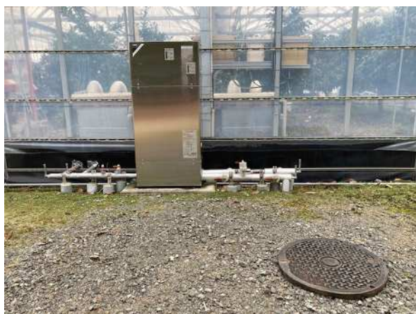
【地中熱ヒートポンプと熱交換井】
