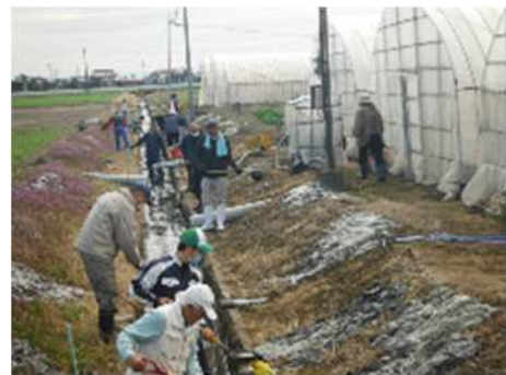
【水路内の泥上げ】
