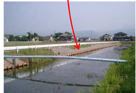
【木柵工による護岸整備】
