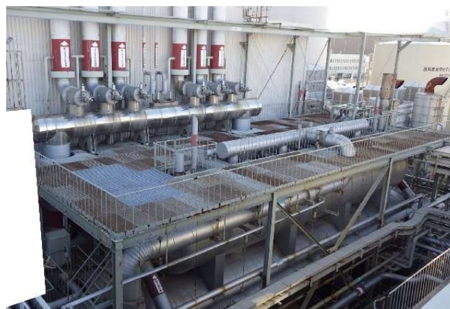
脱気器／湿水分離器逃し弁
