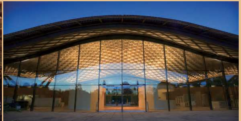
鹿島の広い空に浮かぶ三次曲面の大屋根 鹿島錦の「織り」を連想させる多良岳材を使った木構造
