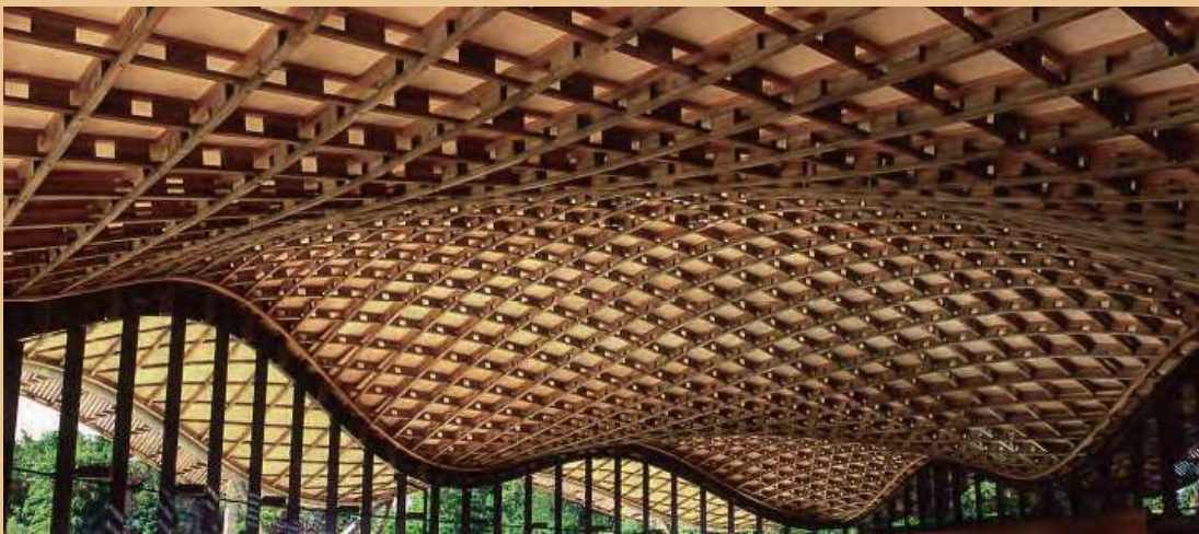
鹿島の広い空に浮かぶ三次曲面の大屋根 鹿島錦の「織り」を連想させる多良岳材を使った木構造
