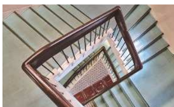
階段手すりのモダンな建造美
