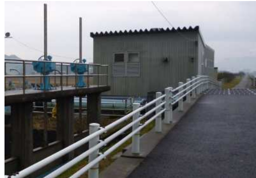
図8 木須川水系の主な河川施設
