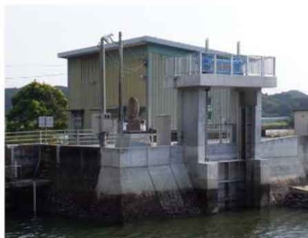
図6 波多津川水系の主な河川施設
