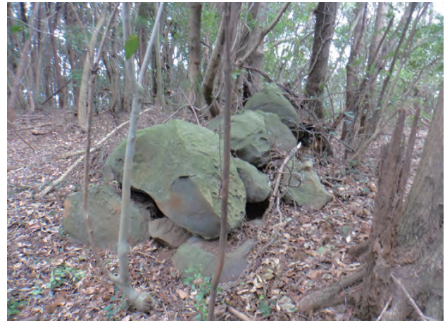
写真73 曲輪A南西隅虎口・石塁(西から)
