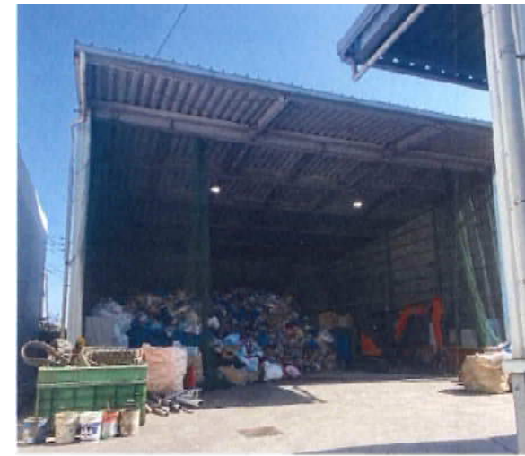
焼却物保管棟（ネットの設置）
