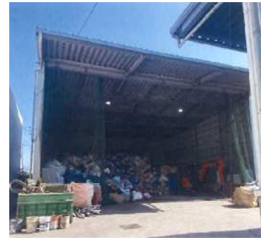
⑩焼却物保管庫棟
