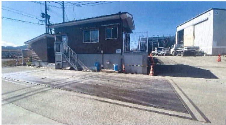
⑦計量事務所
