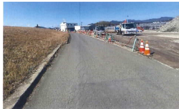
搬入路 東側から撮影
