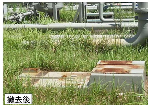
スクリーン洗淨ポンプバックアップポンプの解体撤去の状況
