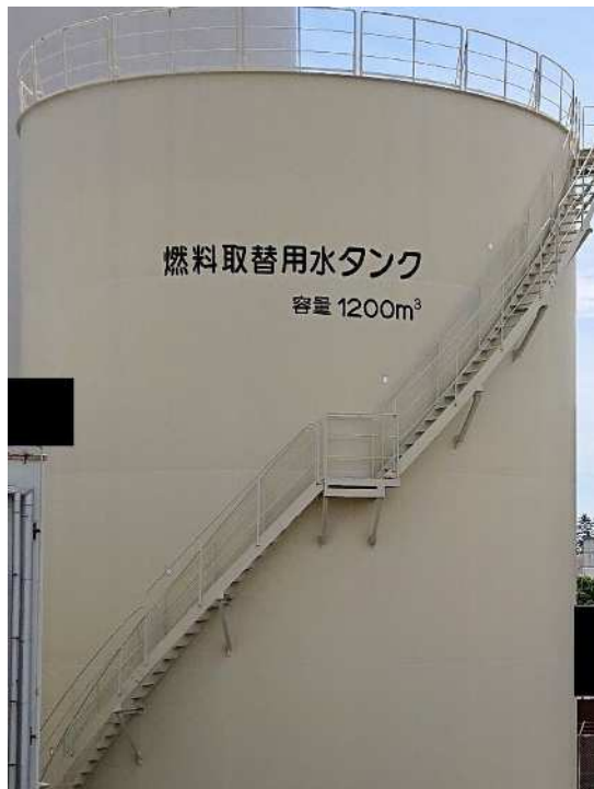
【燃料取替用水タンク】
