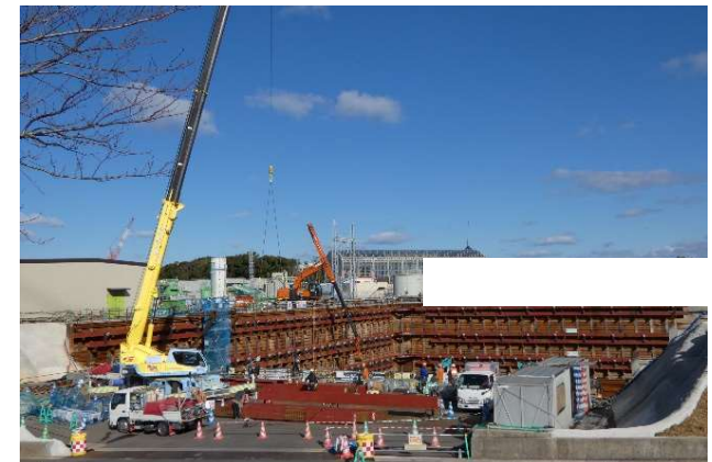
準備工事状況 (掘削工事)
