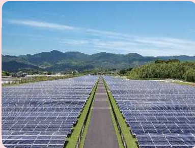
吉野ヶ里メガソーラー発電所
