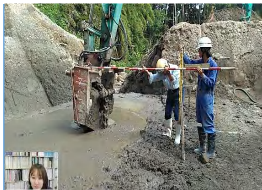
【地盤改良立会状況（現場側）】
