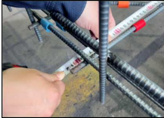
【立会状況（配筋確認；近接）】
