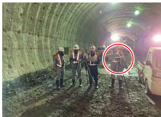
【会議用スピーカーの設置（現場側）】
