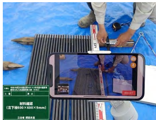
【立会状況（現場側）】
