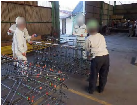
【立会状況（特殊部配筋）】
