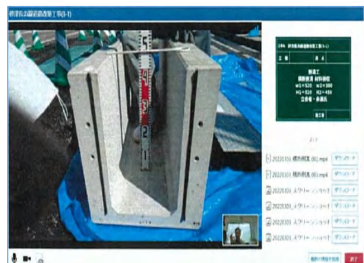
【横断側溝材料検収】
