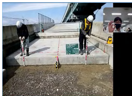
【踏掛版工の出来形検測の様子】
