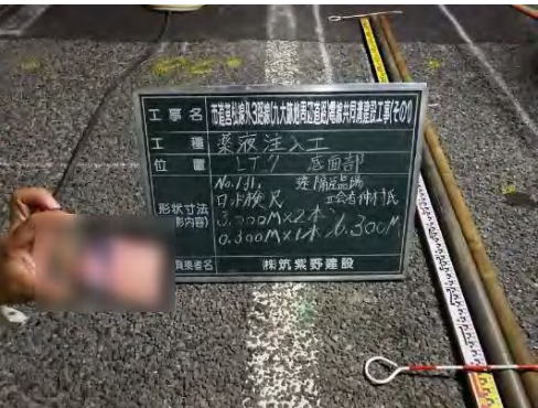
【立会状況（薬液注入ロット検尺）】
