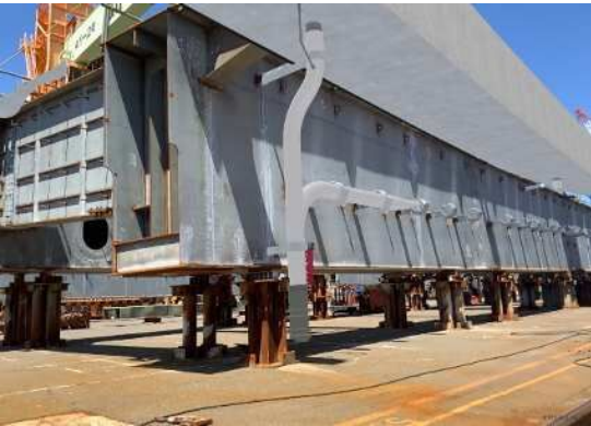
【ARを用いた出来形管理】
