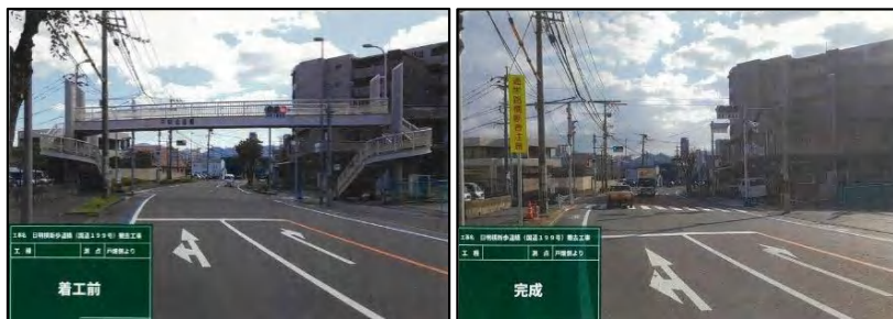
【着工前・完成】
