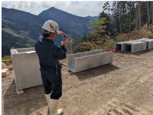
【立会状況（現場側）】
