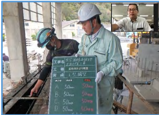
【枠内かぶり 立会状況（工場側）】
