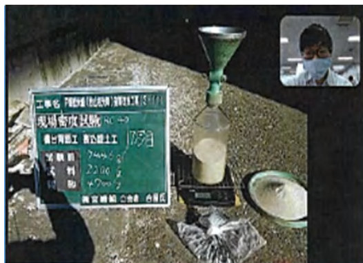
【立会状況（現場側）現場密度試験】
