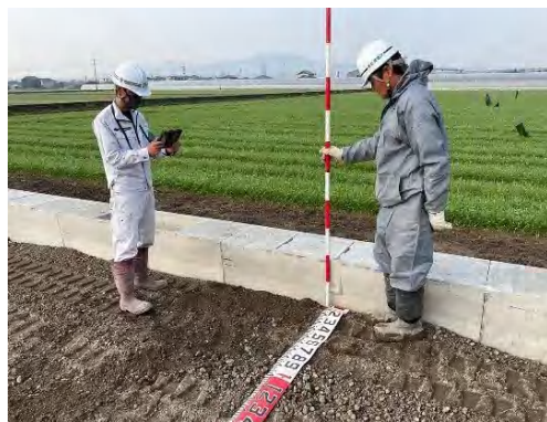
【立会状況（現場側）】
