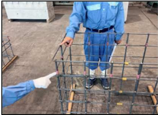
【立会状況（配筋確認）】
