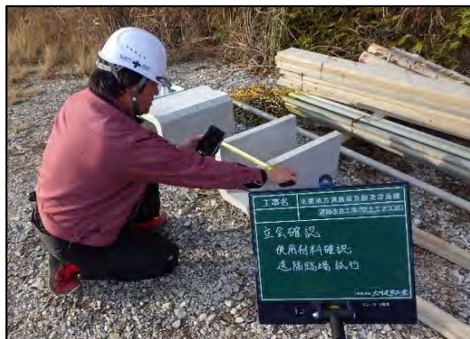
【立会状況（現場側）】
