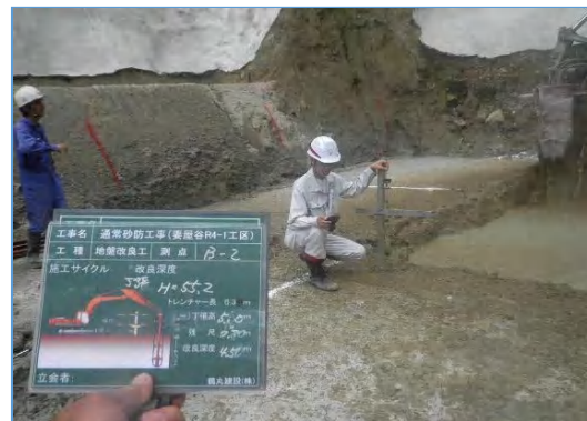
【出来形管理（杭ナビ測量）】
