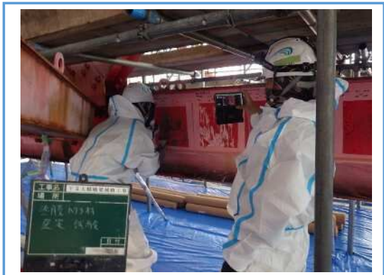
【立会状況（現場側）】
