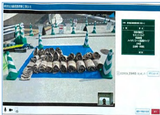
【立会状況（現場側）空袋処理】
