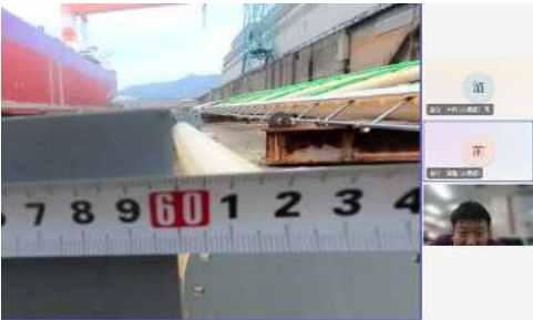
【出来形確認状況（近景）】
