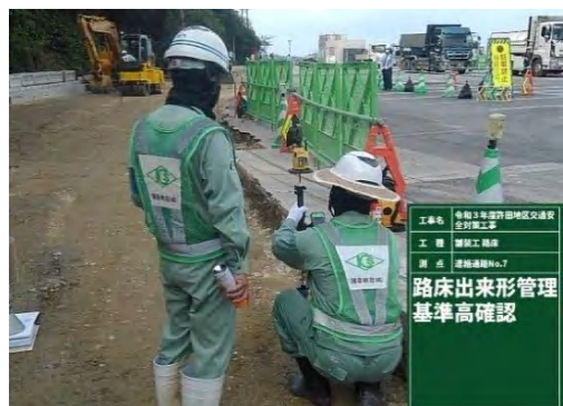
【工夫が分かる写真（杭打ちアプリ）】
