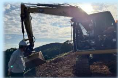
▲ICT土工(盛土)建機の体験
