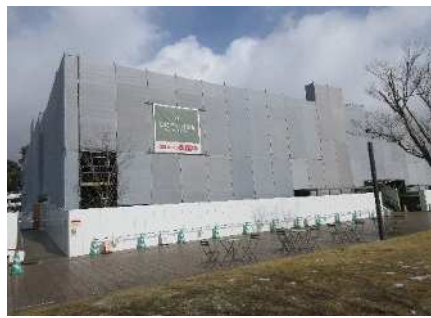
【図書館南側】外壁工事中
