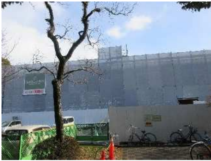
【図書館西側】外壁工事中
