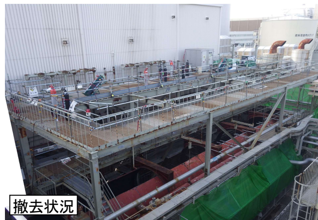
脱気器／湿水分離器逃し弁の解体撤去の状況
