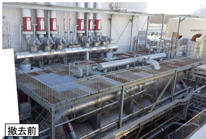
脱気器／湿水分離器逃し弁の解体撤去の状況
