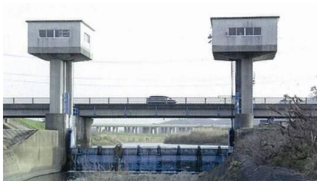
写真-1.9 大日堰 (昭和 57 年 3 月完成)
