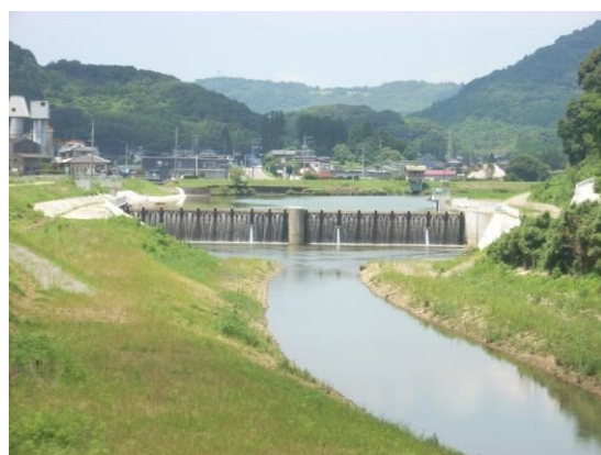
写真-1.12 鰐ノ瀬堰 (平成 26 年 5 月完成)
