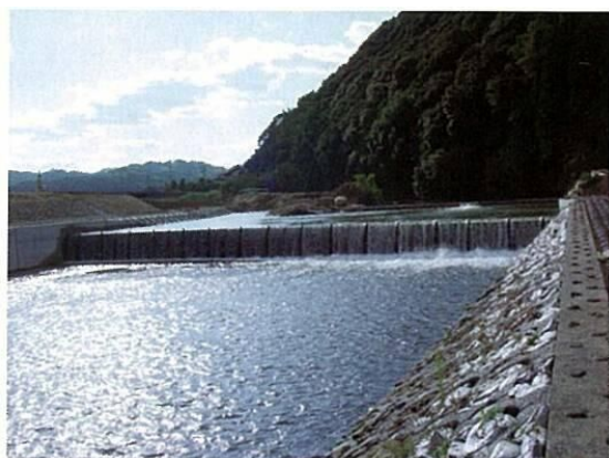
写真-1.11 大井手堰 (平成 17 年 1 月完成)
