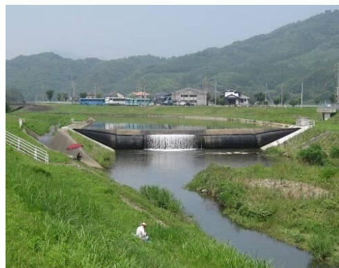
写真-1.10 小井手堰 (平成 17 年 3 月完成)
