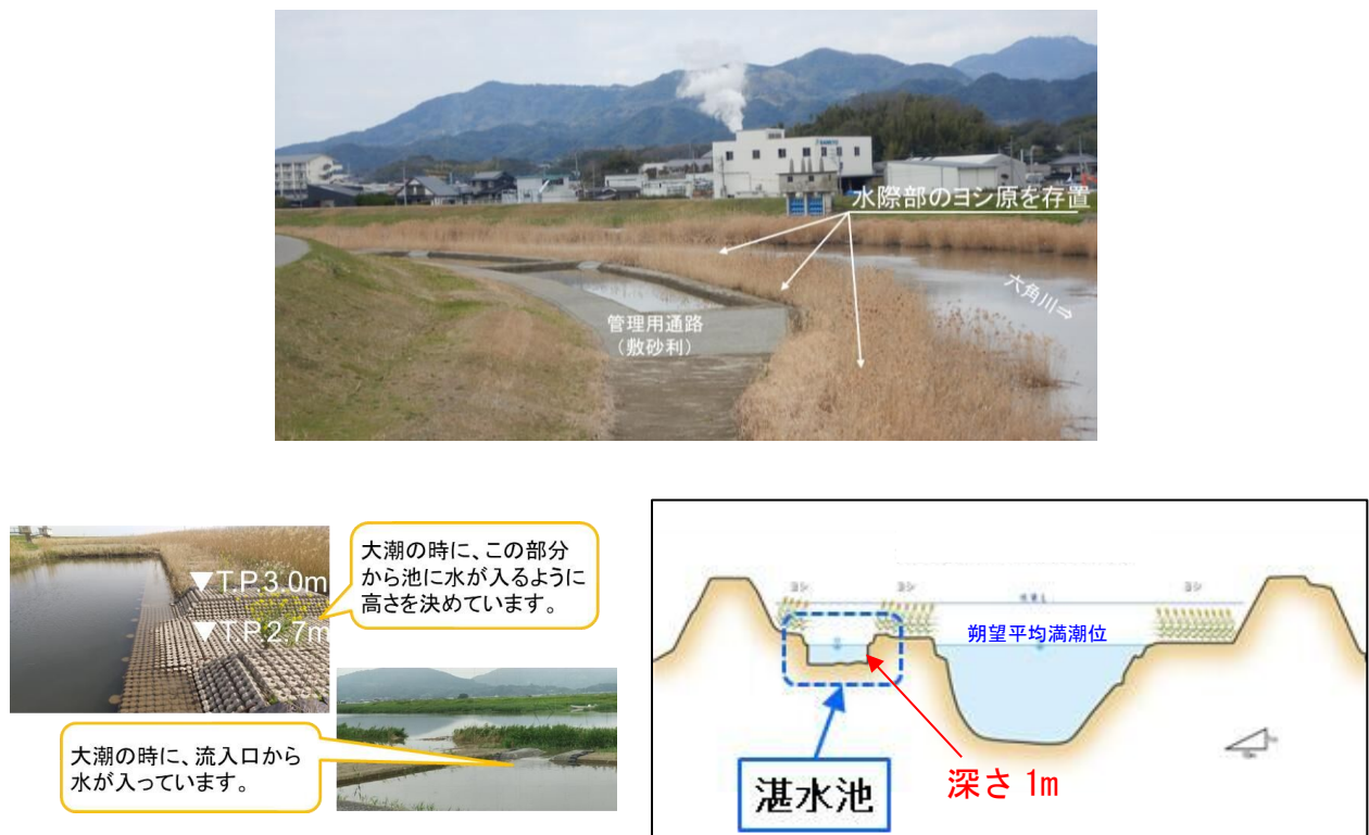
図-1.21 ヨシ繁茂抑制対策の概要
