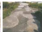
農道の窪みの補修
