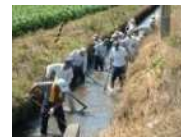
水路の泥上げ
