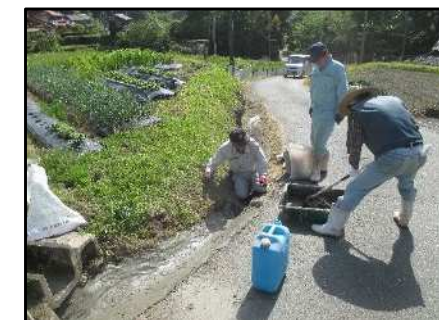
水路補修の様子
