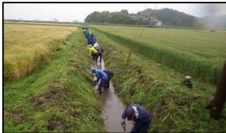
〈水路泥上げの様子〉
