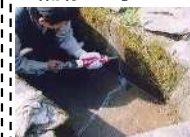
水路のひび割れ補修
