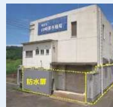
▶ 排水機場機能向上
