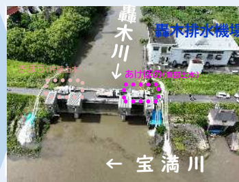
▶ 排水ポンプ車の活用
