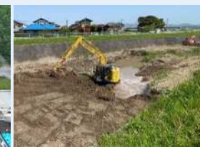
▶ 河川浚渫・伐採
