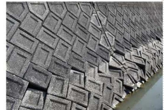
護岸（飛沫水路）の破損状況
