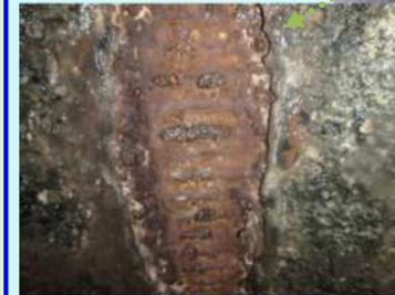
鉄筋の露出・腐食
