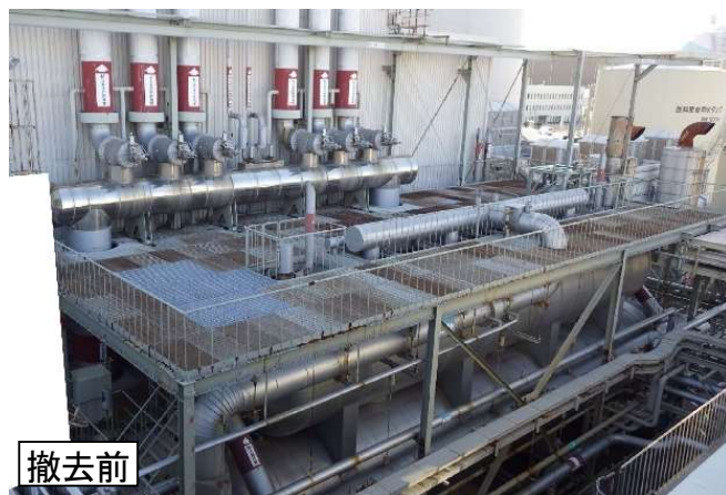
脱気器／湿分分離器逃し弁の解体撤去の状況
