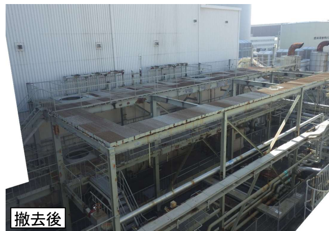
脱気器／湿分分離器逃し弁の解体撤去の状況
