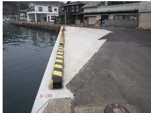
整備後(星賀港 星賀2号物揚場)
