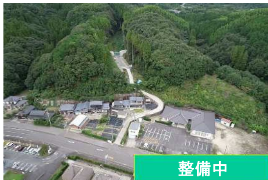
砂防堰堤工(遠景)
