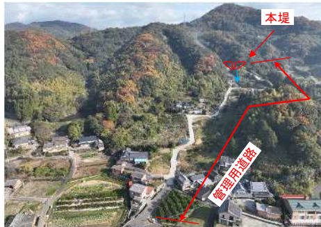
砂防堰堤工(整備中)遠景
