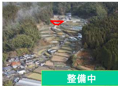
砂防堰堤工(遠景)
