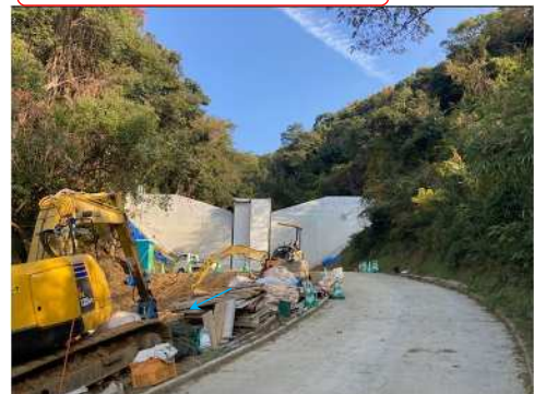
砂防堰堤工(整備中)近景
