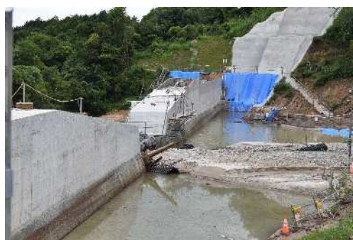
R3.8.15 土石流補足後
