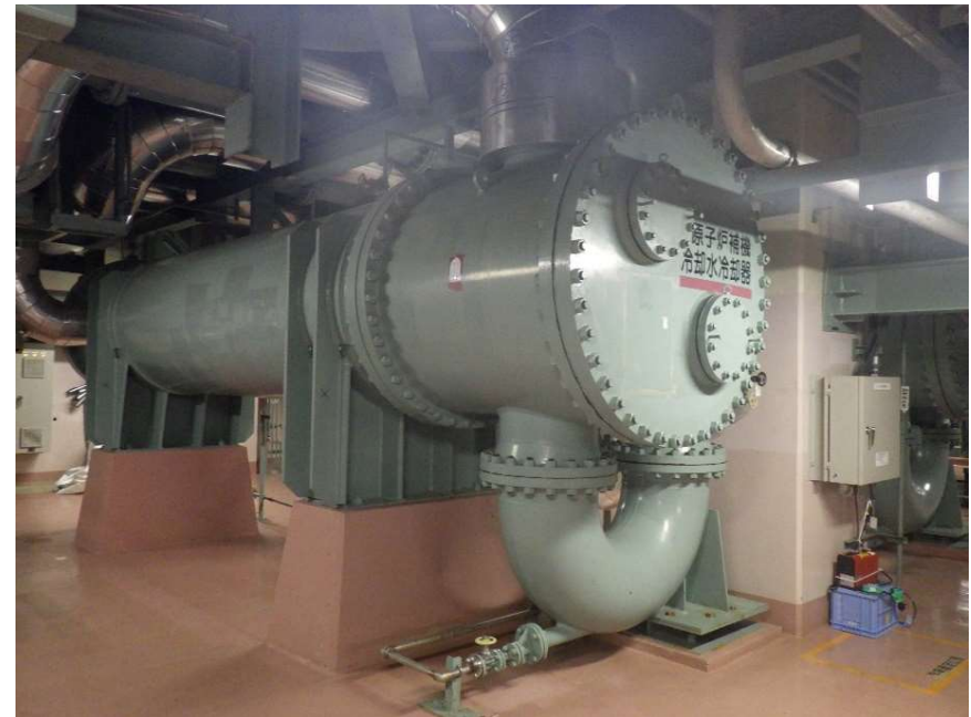
【原子炉補機冷却水冷却器】
