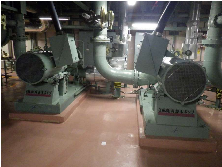
【原子炉補機冷却水ポンプ】
