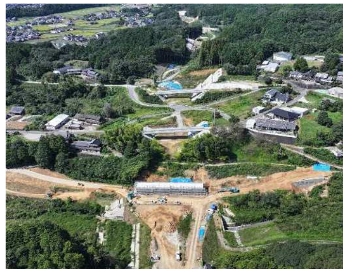
西九州自動車道 伊万里道路 永山地区（函渠工）整備中（R7.9）
