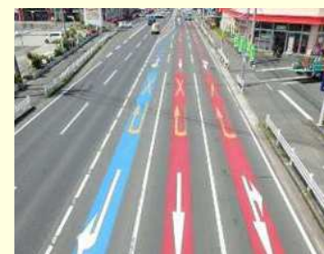
<施工例> 一般国道208号 佐大南交差点 (佐賀市)
