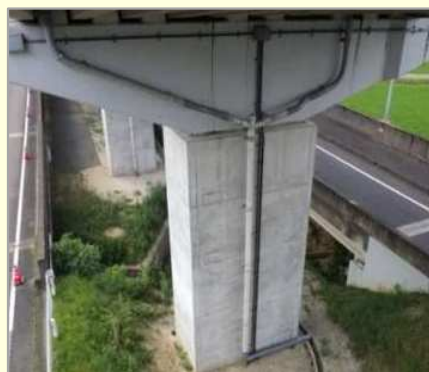
橋脚補強（コンクリート巻立）
