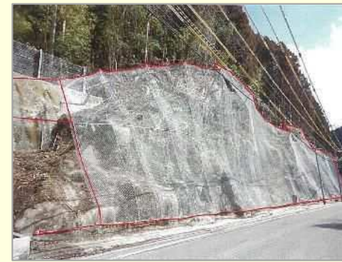
<整備事例>落石対策
