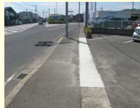
小規模補修（現場打ち側溝蓋設置）
