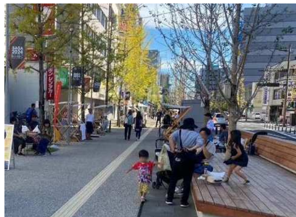
主要地方道佐賀停車場線【さが維新テラス】（佐賀市）
