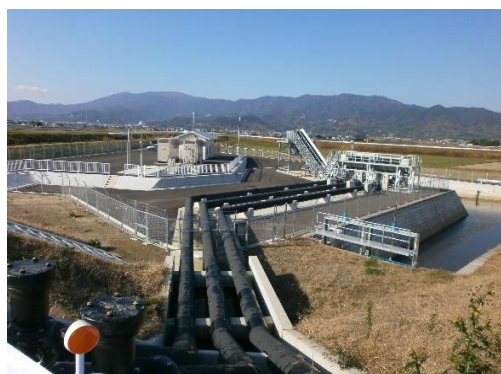
写真2：地盤沈下による湛水被害を解消するために建設された排水機場
