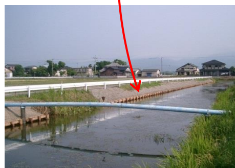
【木柵工による護岸整備】
