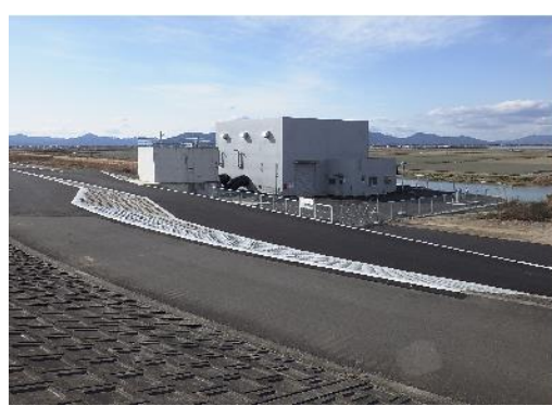
写真2：地盤沈下による湛水被害を解消するために建設された排水機場
